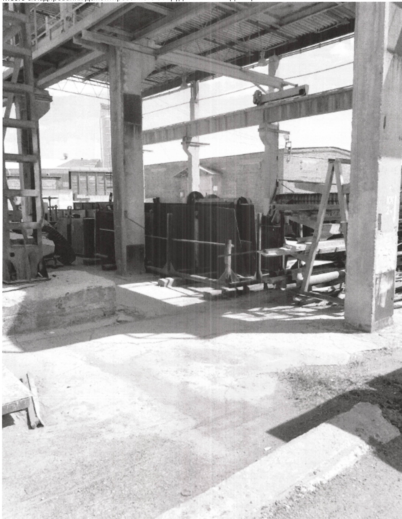
Место складирования демонтированного оборудования на территории ГП:
