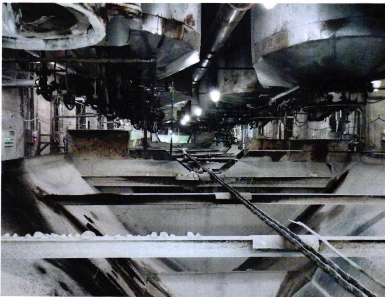
Фото 1 – Общий вид помещения
